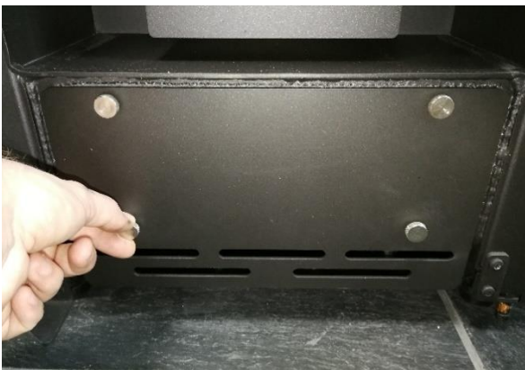
Bild 1: Lösen Sie die 4 Fingerschrauben und nehmen Sie die Abdeckung ab, um die Rauchleitplatte zu lokalisieren.
